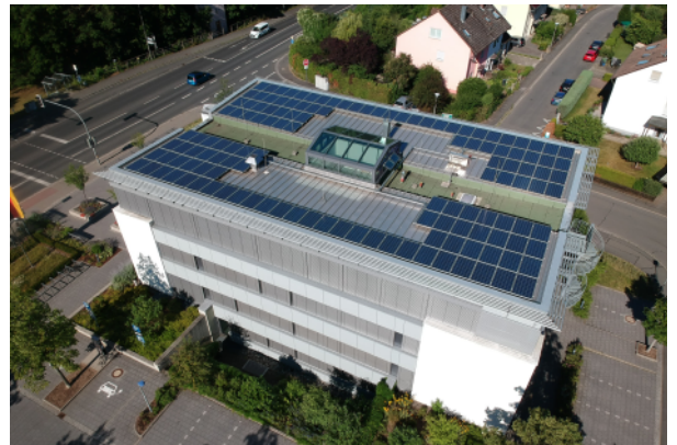
Photovoltaikanlage auf dem Rathaus
